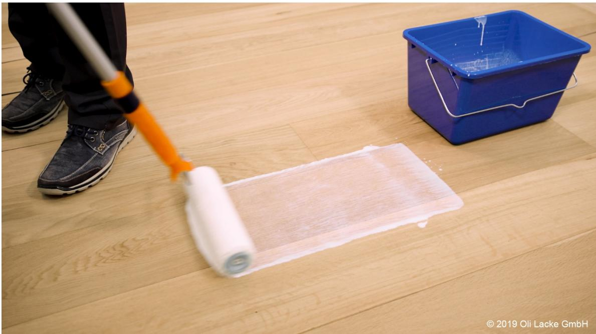
**заглавие:** Паркетный лак обладает очень хорошей наполняющей способностью и наносится равномерно тремя слоями валиком с расходом 100 гр./кв.м. за один слой.
