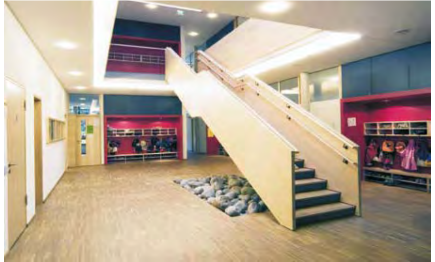
Das Oli-Natura HS Profiol sorgt auch in dieser Kindertagesstätte dafür, dass die Parketttreppe trotz hoher Belastung gut erhalten bleibt.
