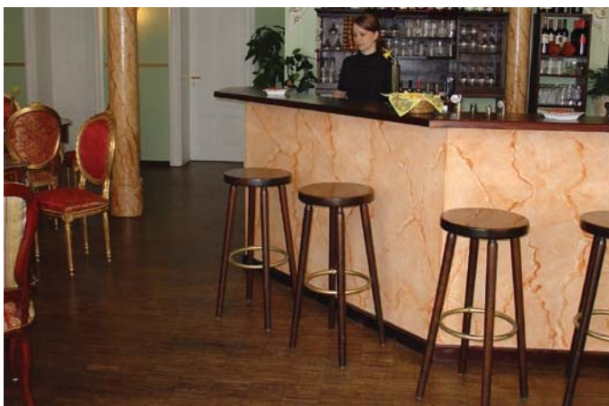
Vor dem Barbereich "glänzt" das kolorierte Parkett aus Hochkantlamellen.
